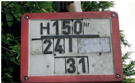
Hydrantenhinweisschild Entfernung vom Schild hier: 2,40 m nach links; 3,10 m nach vorne
